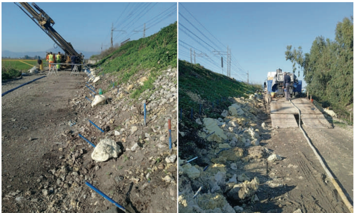
Figura 11: Attività esecutive di iniezione di resine
