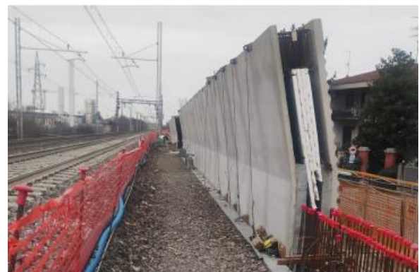
Sistema antirumore Squick brevettato lungo linea ferroviaria (Foto Micos)
