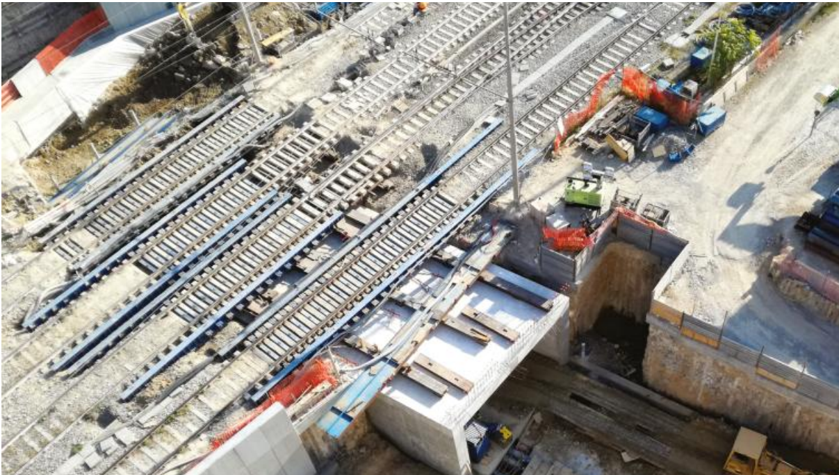
Scatolare a spinta sotto la linea ferroviaria impermealizzato con sistema a "vasca bianca" (Foto Penetron Italia)
